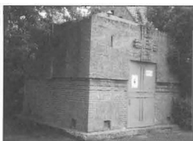
Door J.J. Hellendoorn ontworpen trafohuis.
