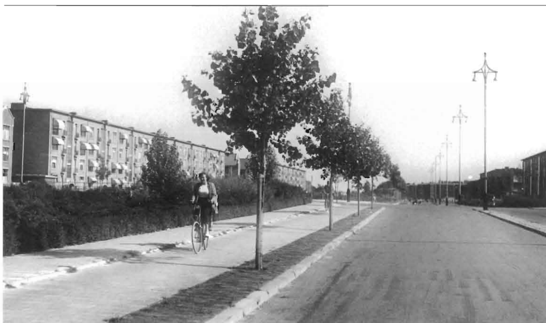
Een reeks Berlage lantaarnpalen naar ontwerp van Piet Zwart met vereenvoudigd draagstel aan de Moerweg omstreeks 1950.
