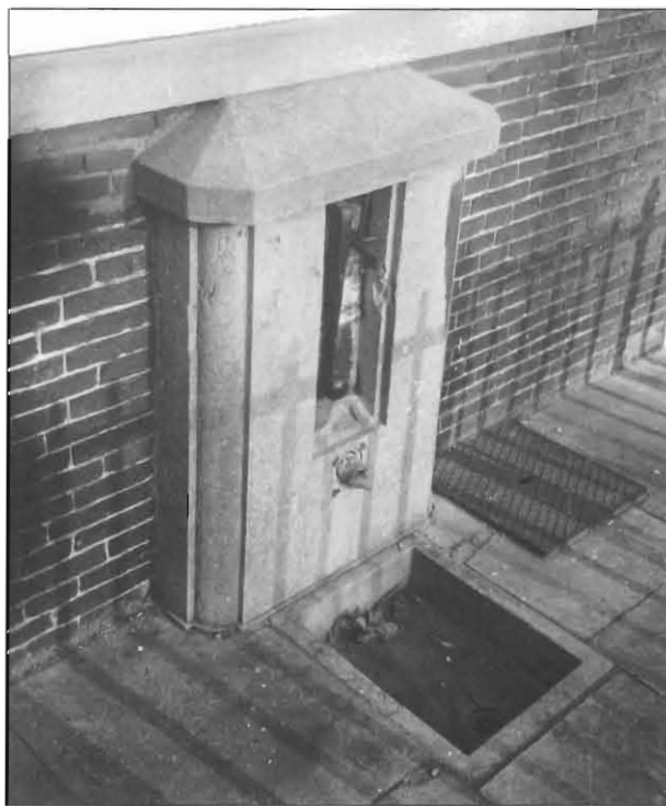
Een natuurstenen pomp tegen de voorgevel van Lange Voorhout 60.
