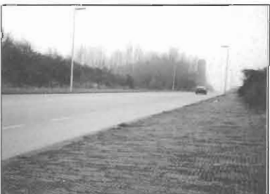
Bestrating met iron bricks op de Nieboerweg.
